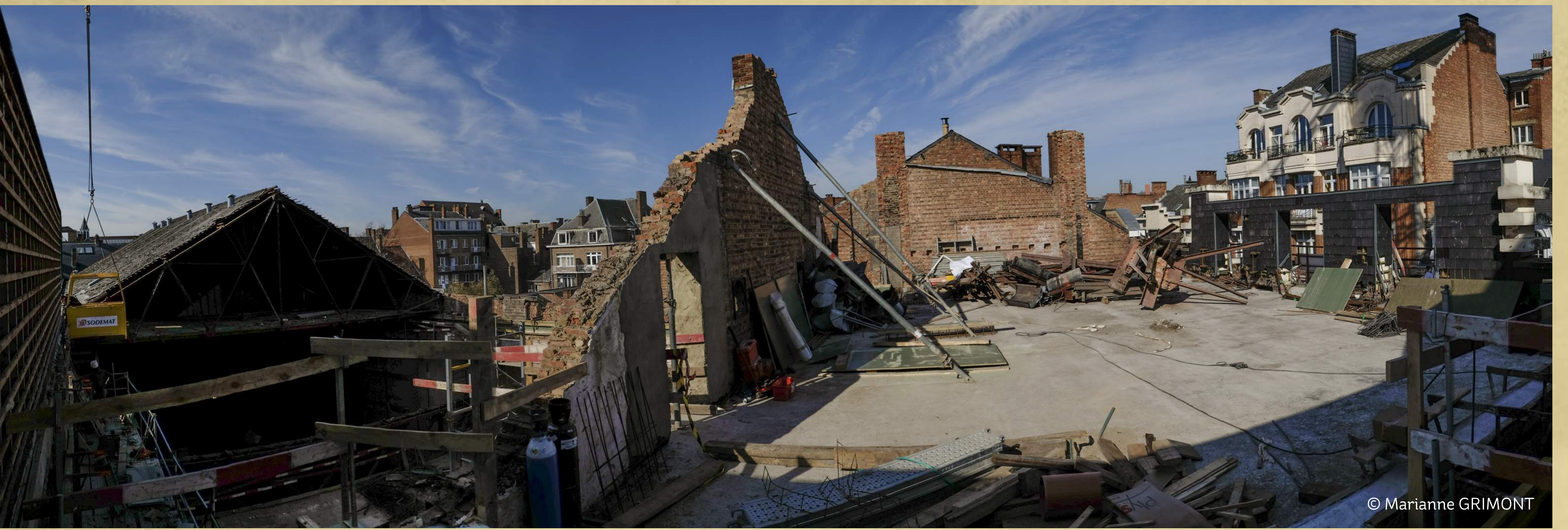
Vue des travaux depuis la toiture
