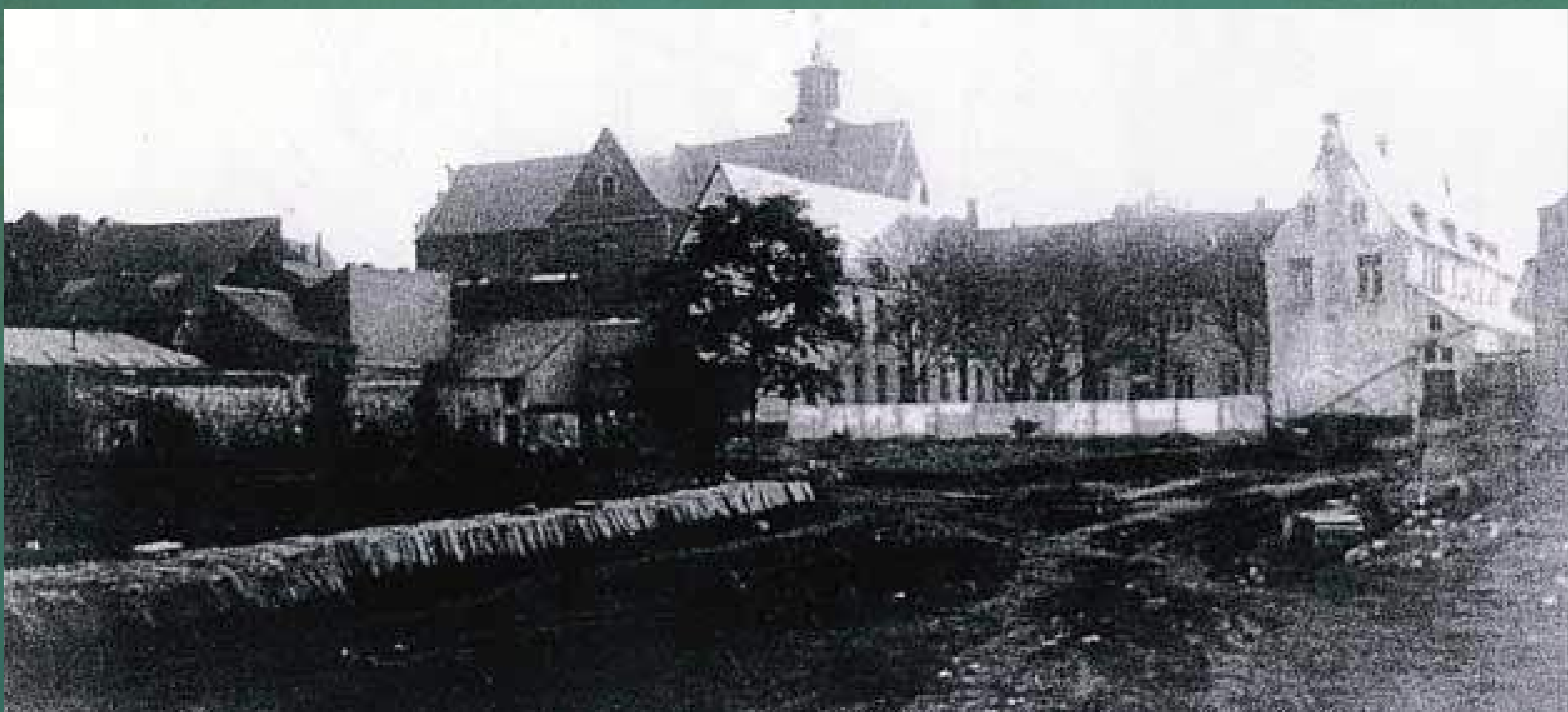
L'ancien couvent des Carmes et l'église Saint Joseph en 1930-1931 lors du percement de la rue des Carmes. L'aile Ouest (située à droite sur la photo) sera abattue pour y construire l'assiette de la voirie.
