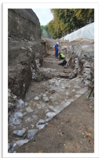
Fig. 2 : En prélude à l'opération archéologique à venir : le suivi des déplacements de canalisations (2016). (Photo : D. Bosquet - © SPW/DGO4, Dir. Archéologie)
