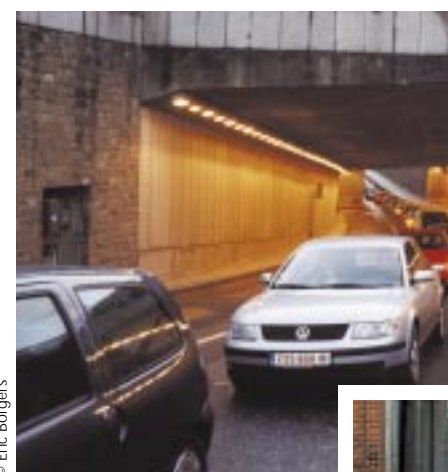
Des files dans le tunnel d'Omalius.
