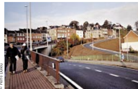
Ouverture de la bretelle reliant le boulevard d'Herbatte à la chaussée de Louvain en décembre 2001.
